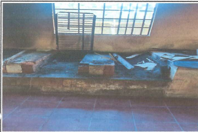
Foto 3: mejoramiento del area de cocina (polletones)
