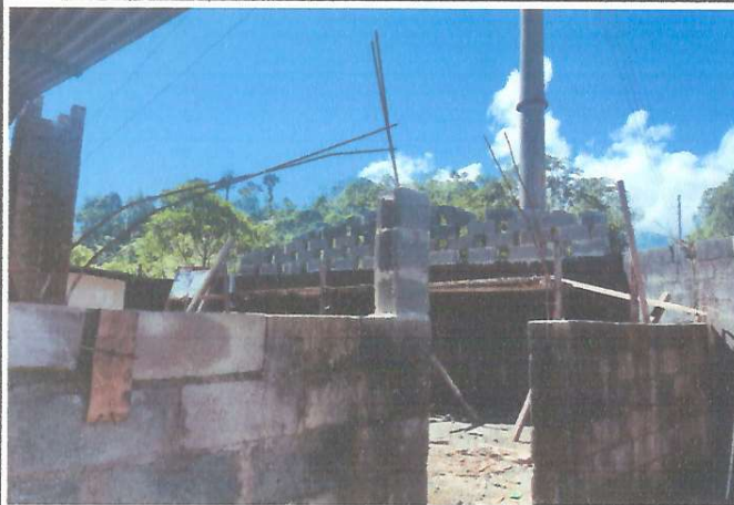
Foto 1: Tejado, estructura y piso de ambiente 1 cocina
